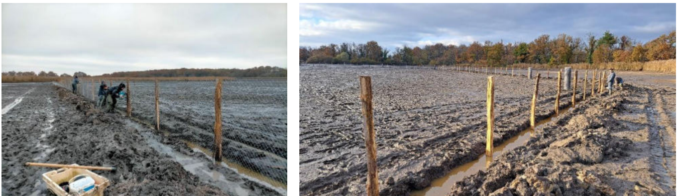
Figure 30 : pose du grillage enterré dans la tranchée et vue finale de l'exclos de la Sous
