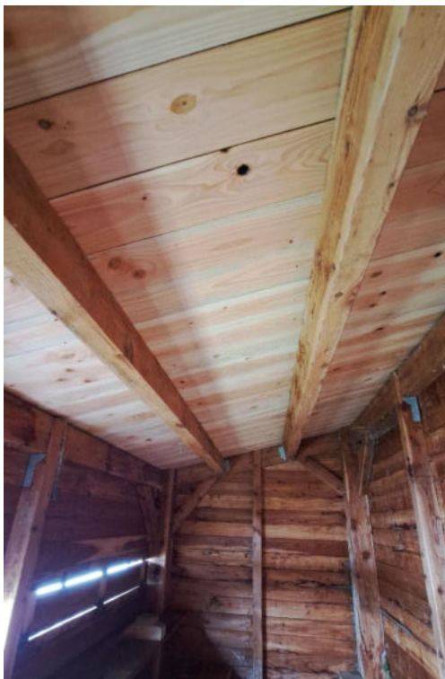
Figure 65 : toiture restaurée de l'observatoire du Grand étang de la Touche
