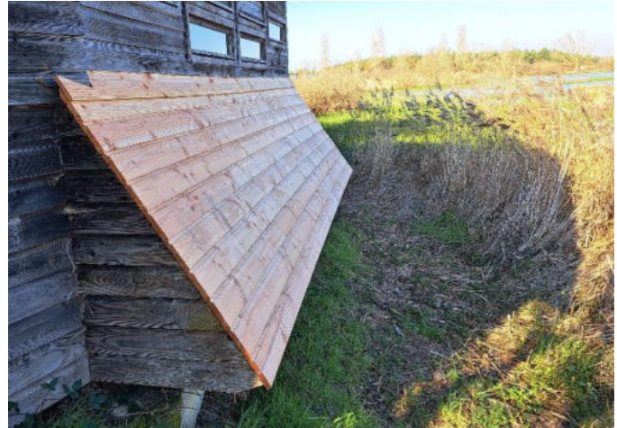
Figure 62 : restauration extérieure de l'avancée "handicapés"
