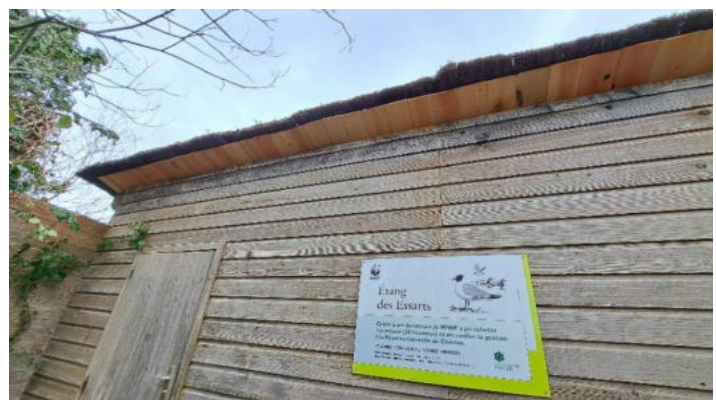
Figure 64 : toiture restaurée de l'observatoire des Essarts
