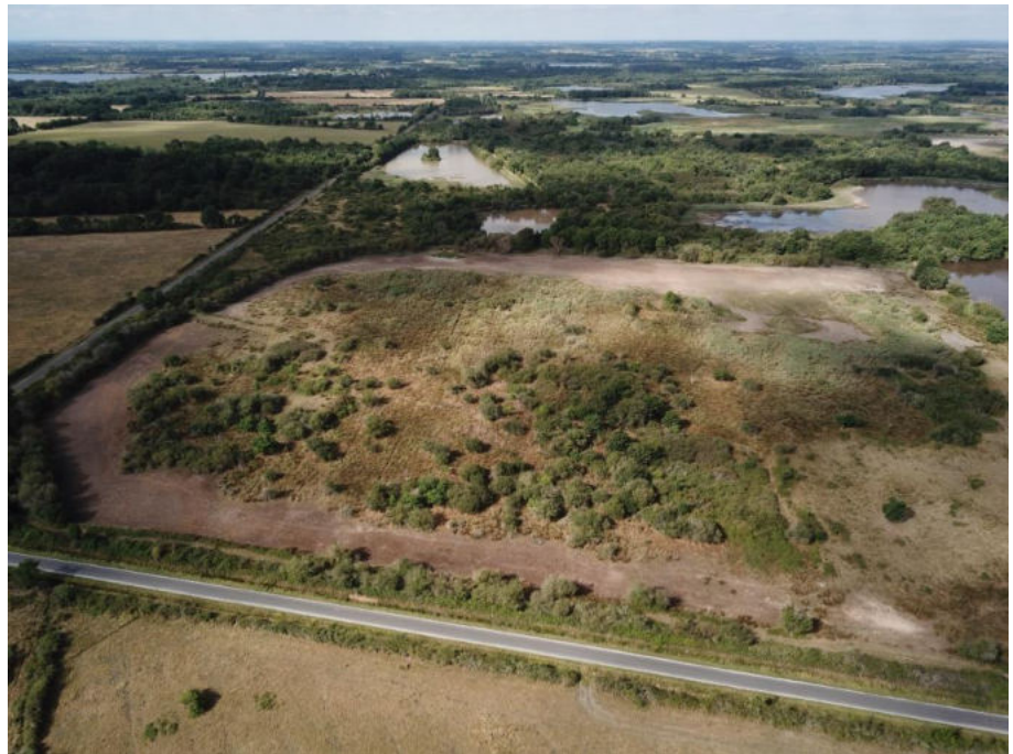
Figure 12 : étang Loup avant travaux
