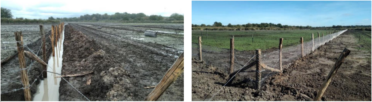
Figure 31 : pose du grillage enterré dans la tranchée et vue finale de l'exclos de Ricot
