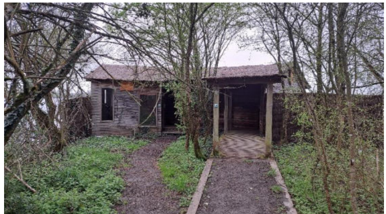
Figure 63 : vue de la toiture de l'observatoire Cistude une fois restaurée
