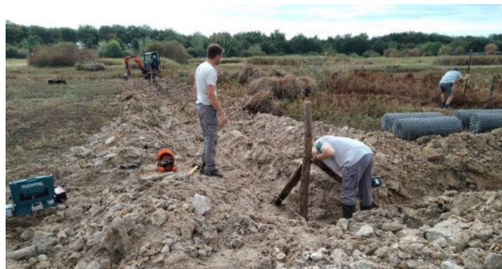
Figure 28 : restauration d'un des exclos de l'étang Cistude
