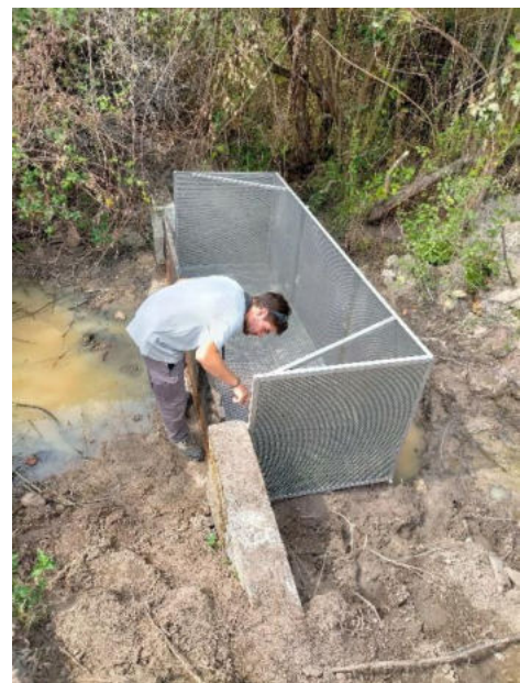
Figure 24 : installation d'un piège à poisson-chat sous la bonde de l'étang Ricot
